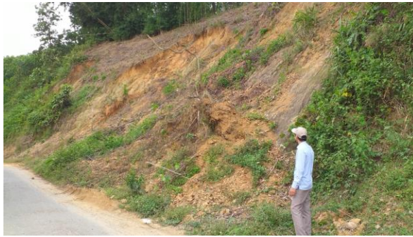
Hình 3. Điểm thường xuyên xảy ra trượt lở trên mái dốc dọc tuyến đường liên xã ở thôn Lập, Thượng Nhật
