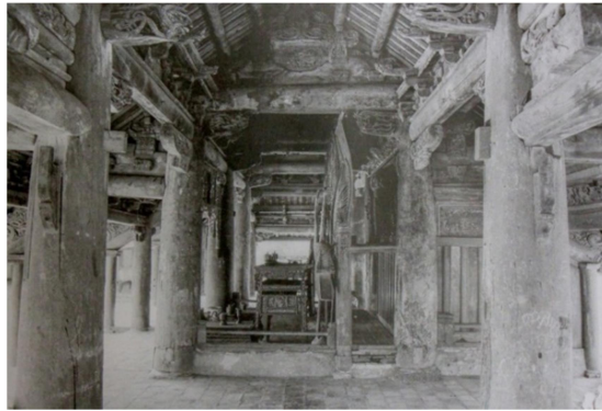
Hình 2. Kết cấu khung gỗ của Đình Tây Đằng, Thị trấn Tây Đằng, huyện Ba Vì, Hà Nội [8]
